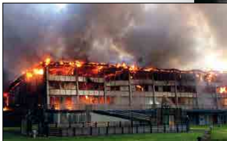
Incendie piscine de Valenciennes en 2014
